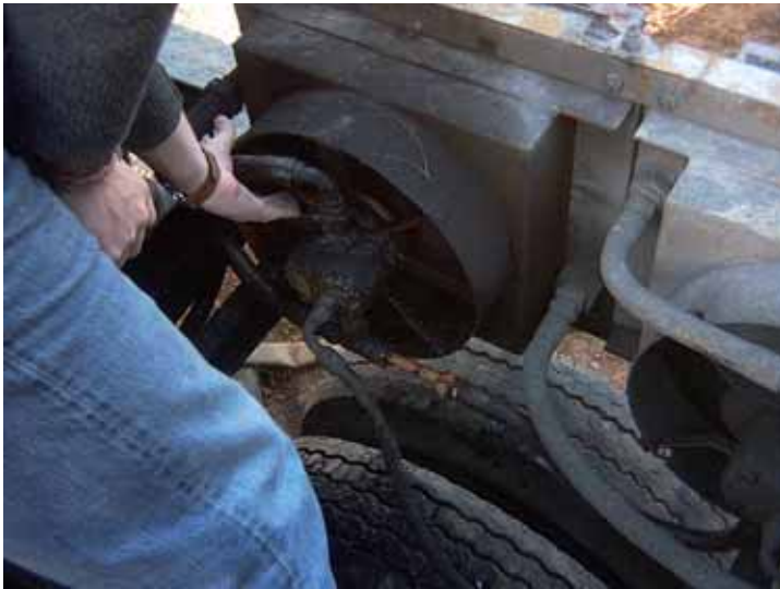
► N° 1: Detalle fuga de manguito junto a ventilador del sistema de refrigeración.
