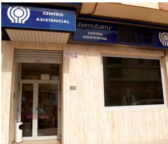
* Exterior Centro Sax
