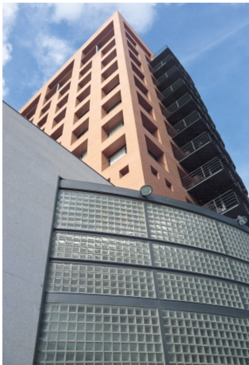
Sede del Consejo Económico y Social, que se erige sobre el solar del antiguo Edificio "Pueblo", en la calle Huertas.
