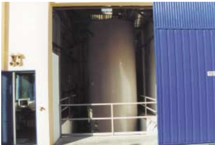
Tanques de proceso de Poliisocianato Aromático en solución y Poliuretano Aromático en solución (dos tanques con capacidad de 30.000 litros cada uno).
